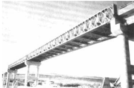
图2 “321”钢桥架的杭州钱塘江五桥施工用大型栈桥钢桥。
